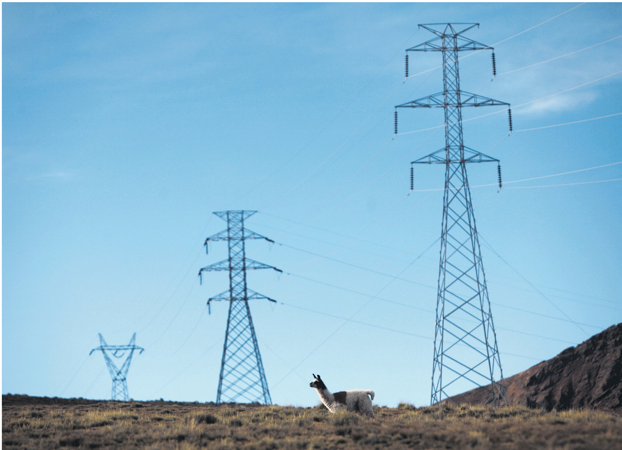
Een lama loopt langs een elektriciteitsmast in El Alto, een voorstad van de Boliviaanse hoofdstad La Paz. Foto AP
